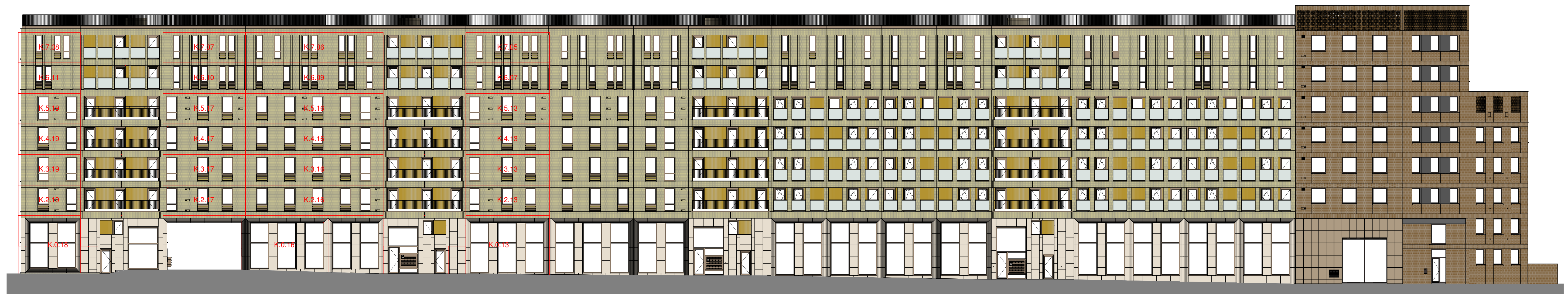
Achtergevel Klif en Poort
